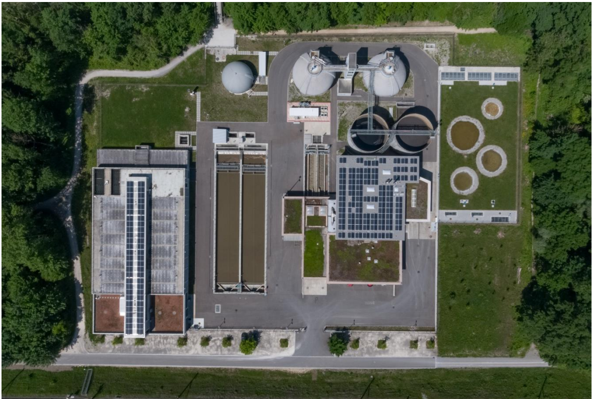
ARA Wasserschloss mit neuen Photovoltaikanlagen auf Passerelle Biofilter und Betriebsgebäude
